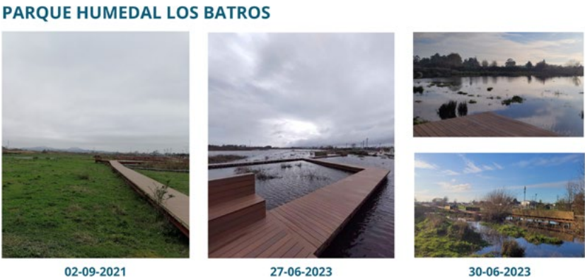
Figura 5. Parque Humedal Los Batros, una infraestructura verde-azul para la adaptación ante inundaciones. Imagen de izquierda en verano y derecha en junio, durante un evento de inundación.
