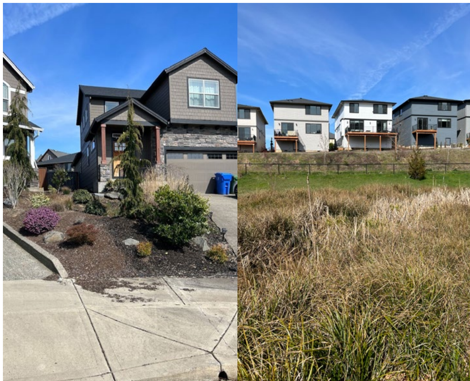
Figura 7. Barrio con DUS (Drenaje Urbano Sustentable) con jardines de lluvia, zanjas filtrantes, pavimentos filtrantes y humedales en City of Gresham Portland USA.
